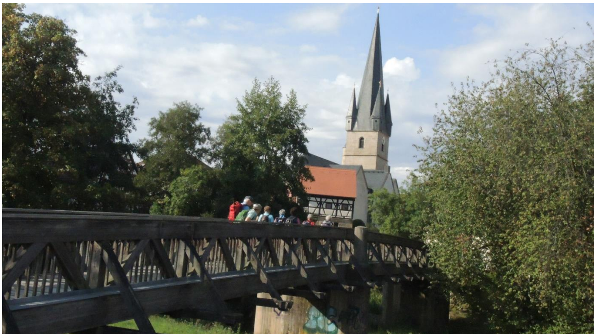
Mühlensteg über die Baunach
